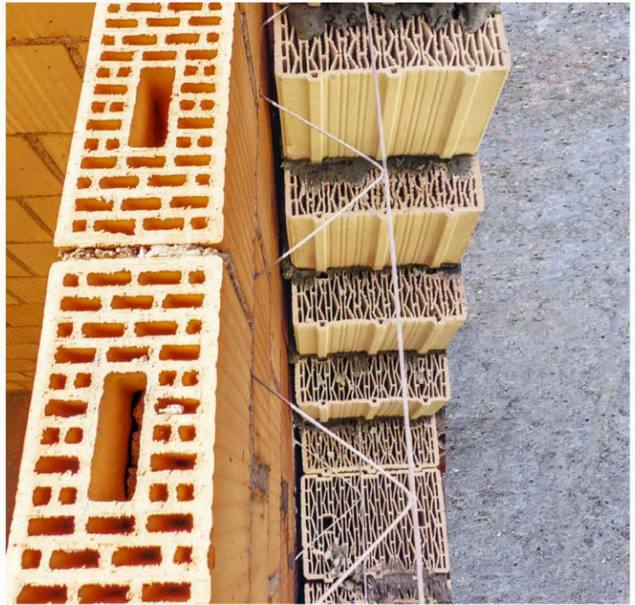
Das ökologische Backsteinsystem verbindet Dämm- und Tragfunktion.
